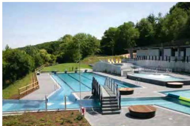
▲ Variable Wasserfläche mit Schotts (Freibad Stromberg)
