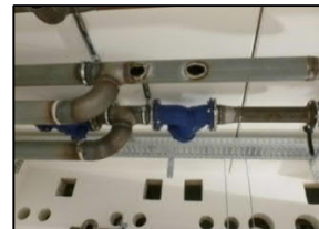
Abbildung 5: Schmutzfänger mit größerer Dimension in Rohrleitung Zeta =
