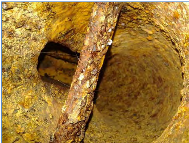
Abbildung 4: Inkrustationen an der Beckenwasserpumpe im Hallenbad Stolberg, Glashütter Weiher
