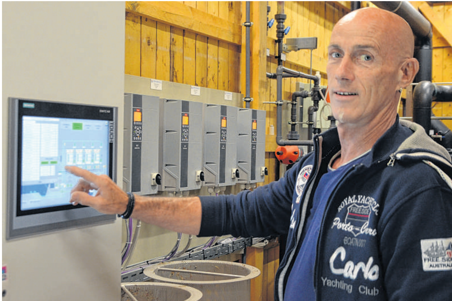
Dietmar Michel, Schwimmmeister im Waldfreibad Gudenhagen, setzt die neue Filtrieranlage im Filterhaus per Computer in Bewegung. Dann läuft alles vollkommen automatisch. Die Filterspülung ist nach knapp 12 Minuten bereits abgeschlossen.
