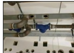
Abbildung 5: Schmutzfänger mit größerer Dimension in Rohrleitung Zeta =
